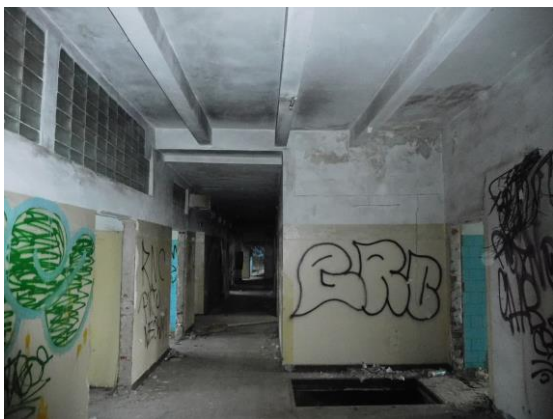
Monolitické ŽB trámové stropy v jádru původní mlékárny, střecha výrobní
