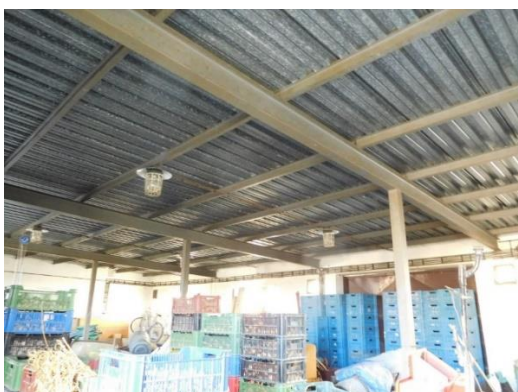
SO 02 Garáže – konstrukce stropu/střechy, pohled na garáže
